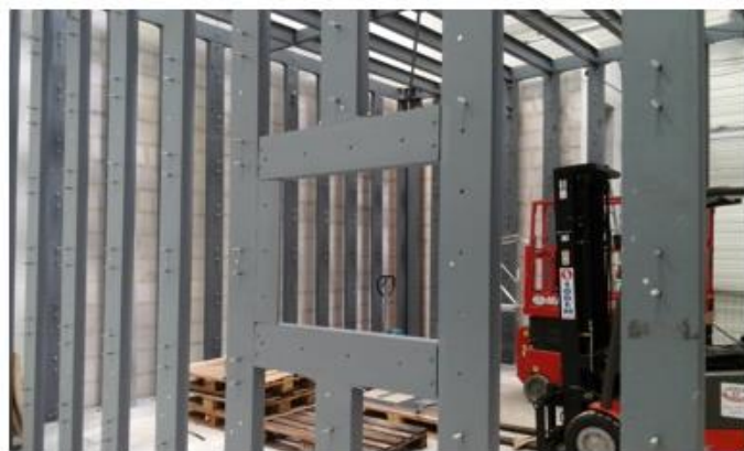
a- Struture métallique
