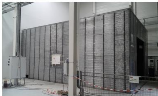
d- Structure métallique + parois en plomb
