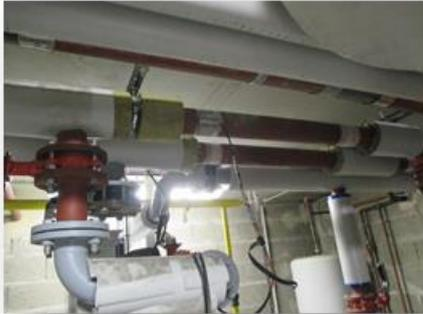
Figure 4 : Capteurs de monitoring de structures tubulaires via la technique des ondes ultrasonores guidées installés en l'occurrence dans une chaufferie, dans les locaux de l'Institut de Soudure de Yutz (57).
