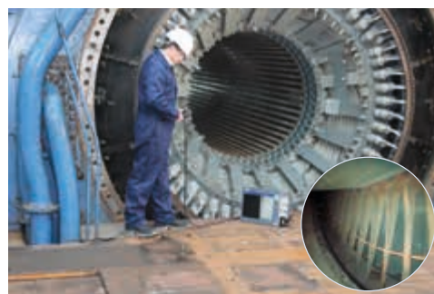
Contrôle d'une turbine à gaz au moyen d'un vidéo-endoscope et de l'unité de documentation TECHNO PACK® T LED
